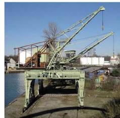
zu sanierender Portalrehrkanal
