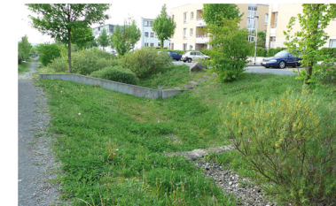
Beispielbild Regenrückhalteelementen mit seitlichem Baumbestand
