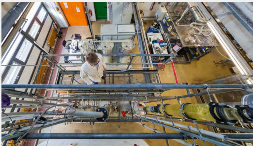
Produktion ist ein Forschungsschwerpunkt der TU Dortmund: In dieser Pilotanlage wird ein Verfahren zur Gaswäsche entwickelt.
